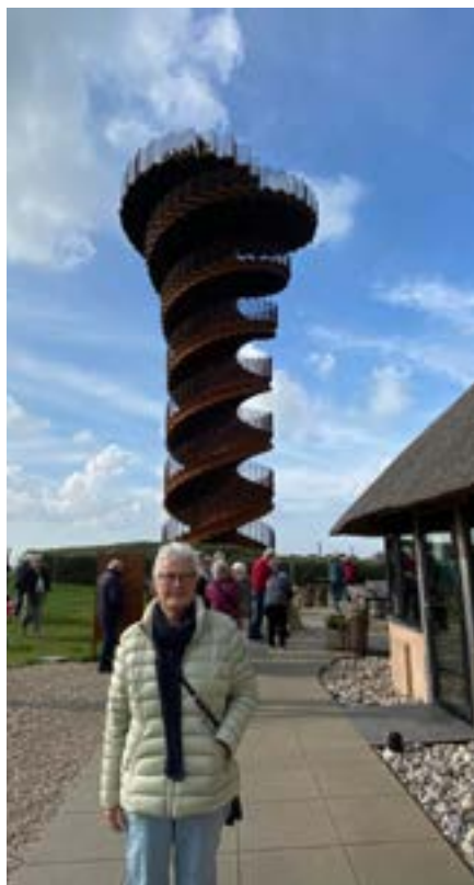
Ved Marsk Tower
